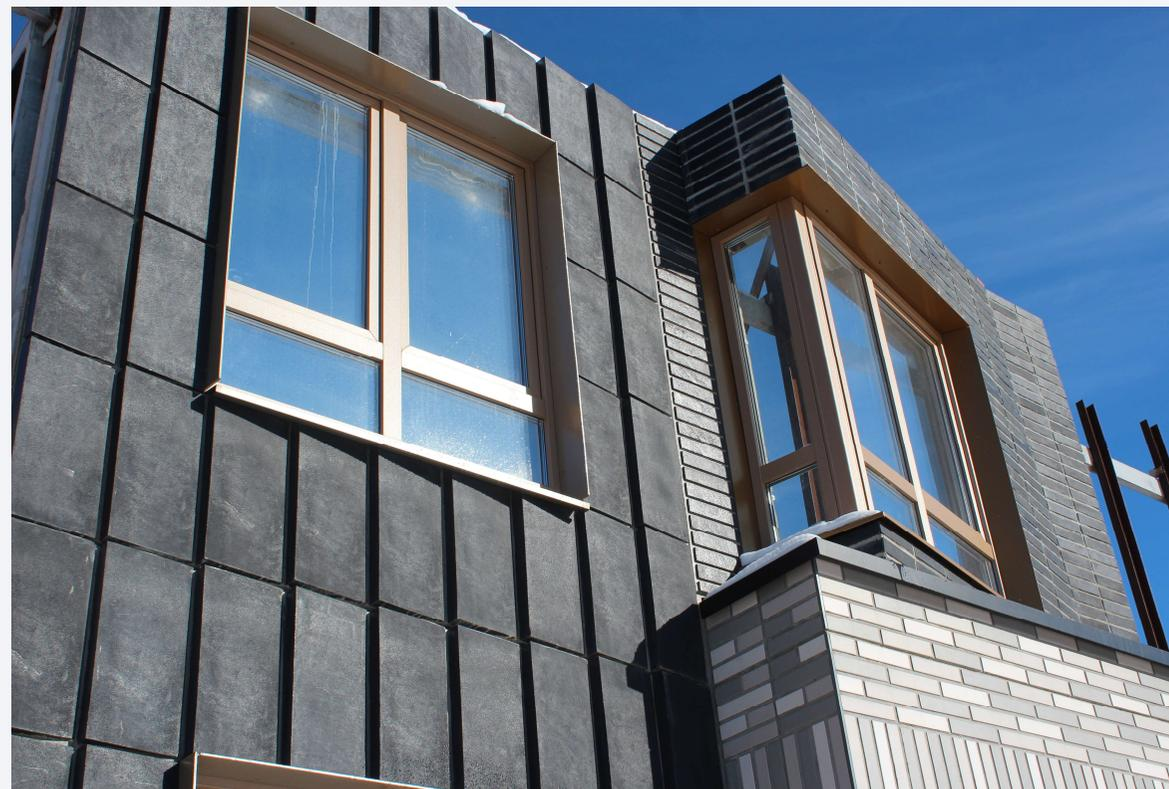
Панели с плиткой сложной формы, примыкание к НВФ
