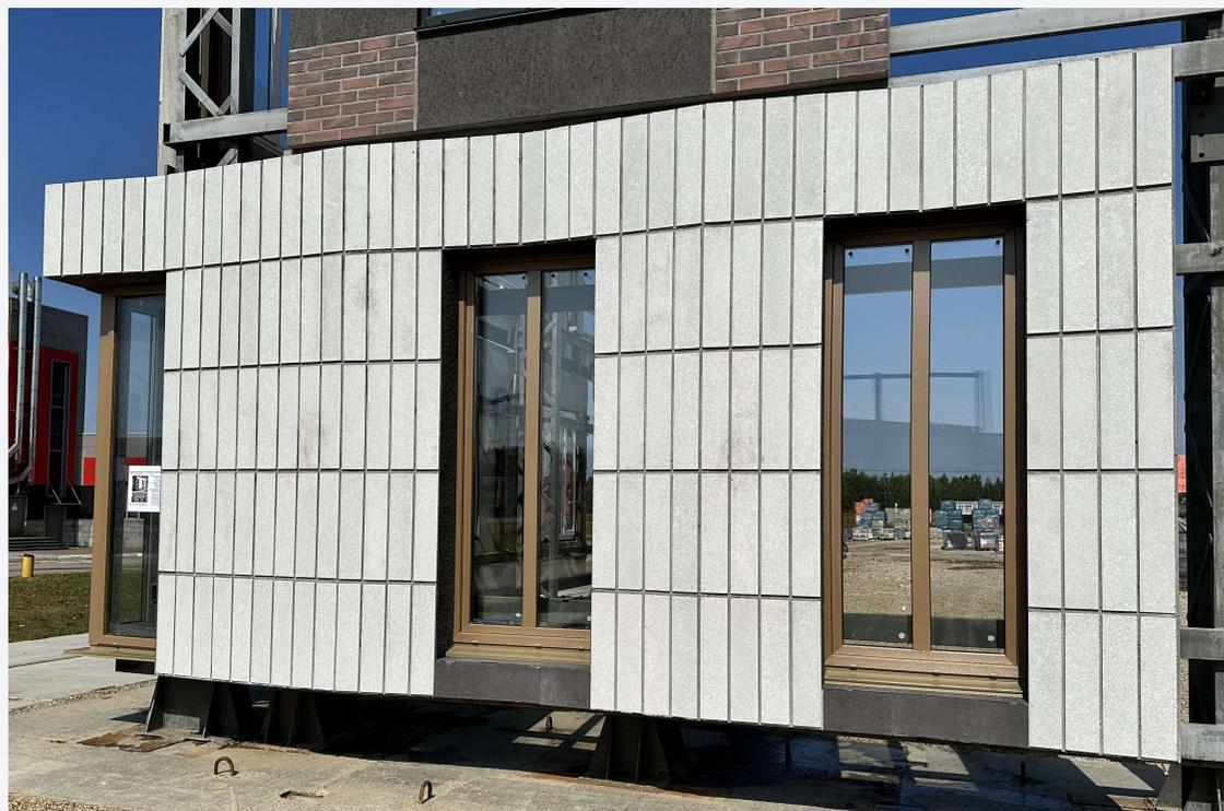
Объемные панели с бетонной плиткой и сложной геометрией наружного слоя
